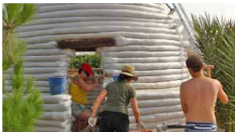
Esta técnica de construcción conocida como SúperAdobe, ya ha alcanzado popularidad en otros países. En el interior, los acabados pueden ser tan simples o sofisticados como deseen los auto-construtores.
